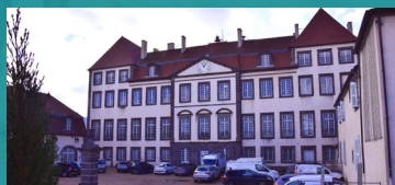
Antenne de Combronde 2
