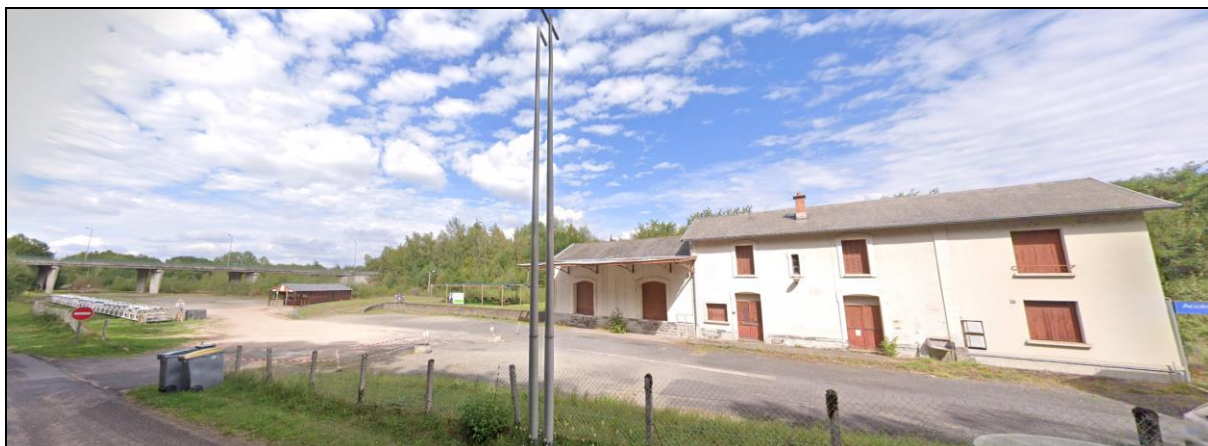
Vue actuelle de la gare. À gauche, la cabane et la voie de départ du vélorail.
